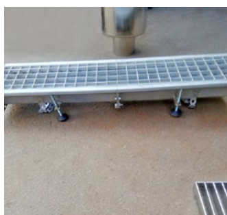
Лоток с базовой полкой, полученной плющением с мембраной
